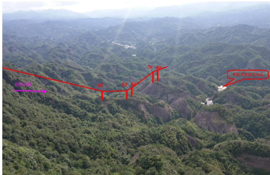
照片 2 索道 4#、5#、6#、7#、8# 支架位置、自然斜坡 XP1 (拍摄地点: 八角寨观景台; 拍摄方向: 230°)
