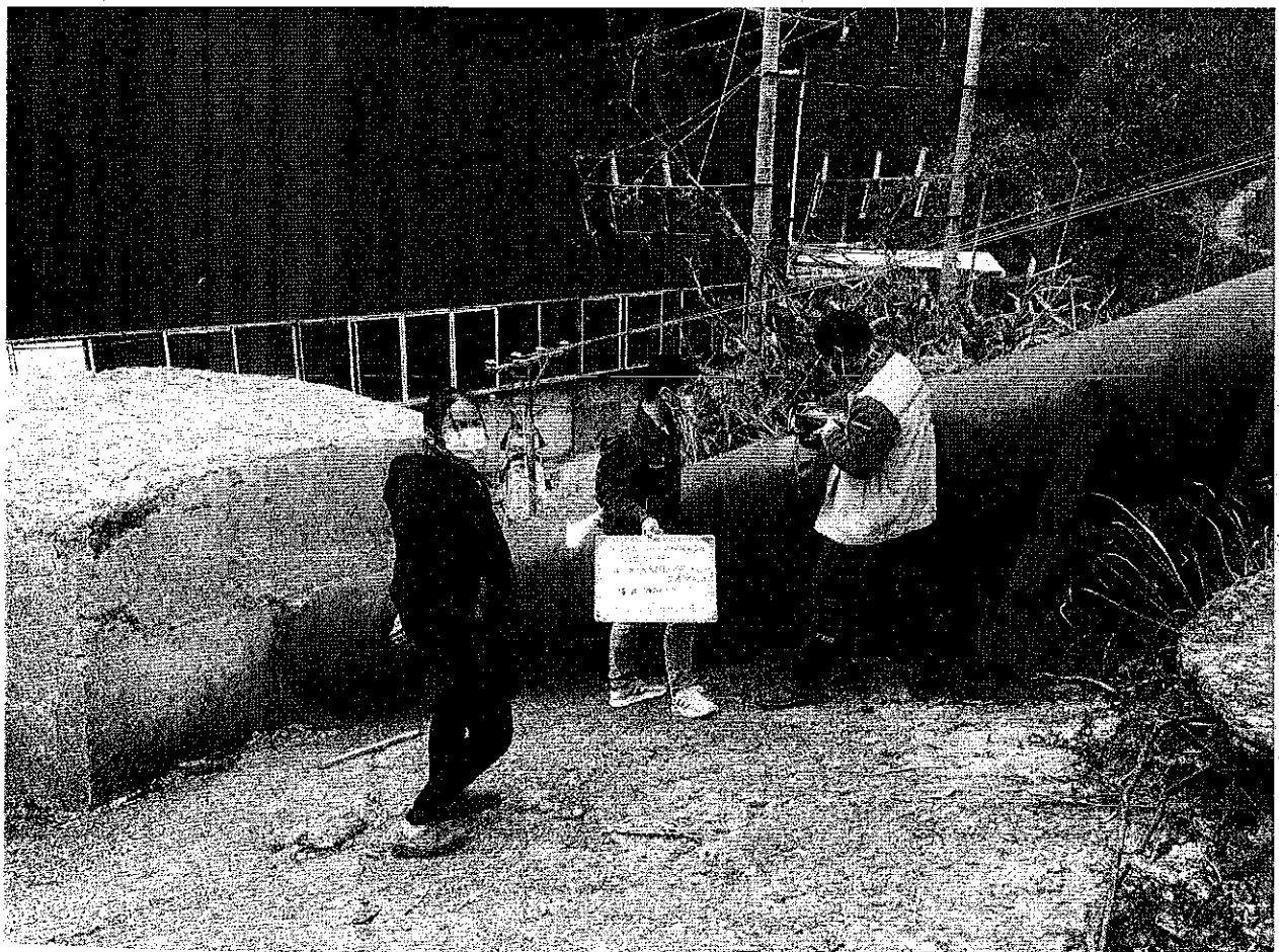
照片 2 超声探伤法压力钢管焊缝内部质量检测 (5号镇墩上游 4m)
