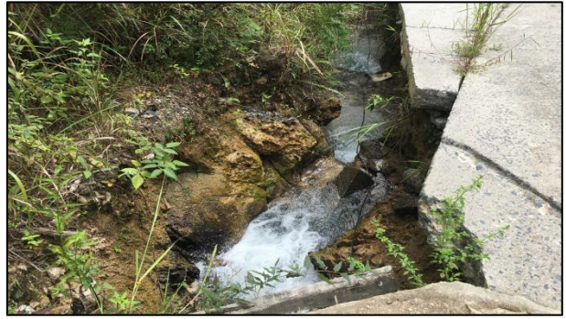
排污口下游约 300m 溪沟
