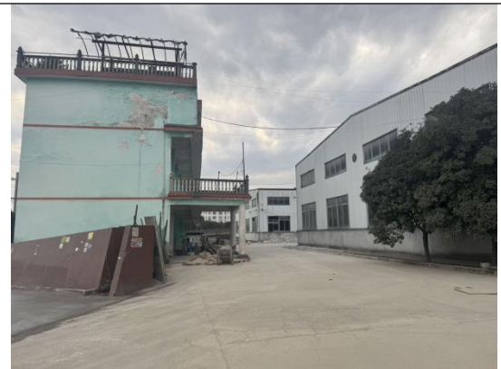
项目北面现状
