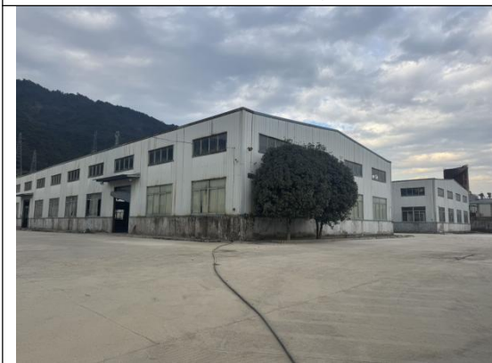
项目厂房现状
