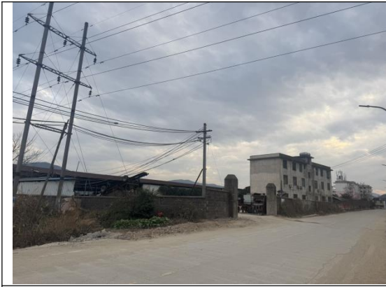
项目东面现状
