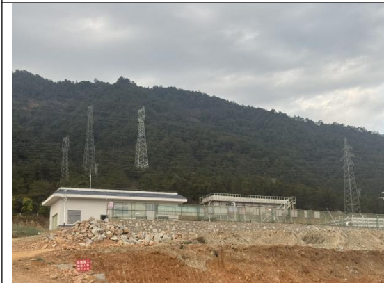
项目西面现状
