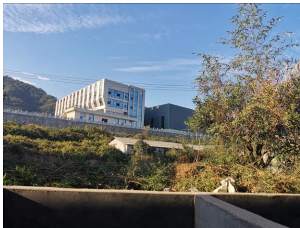
图 3 项目地块西面现状
