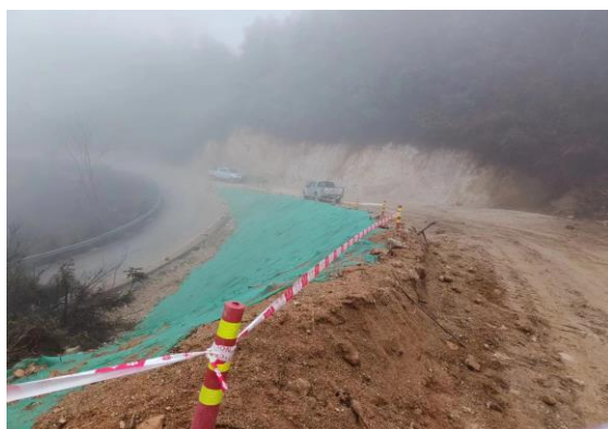
边坡播撒草籽并覆盖绿色土工布
