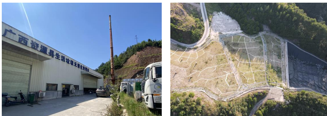
资源县垃圾无害化处理站（停产中） 资源县学子冲生活垃圾填埋场（封场）
