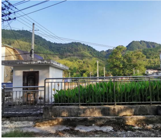
杉树岭生活污水处理厂
