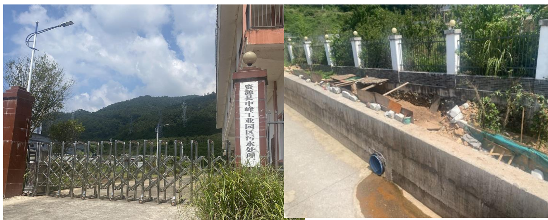
图3.3-3 资源县中峰工业园区污水处理厂现状图
